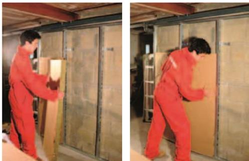
l'isolant. La mise en œuvre est dictée par le DTU 25-31 et les instructions du fabricant du parement intérieur.
